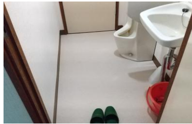
改修されたトイレの床
