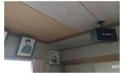
改修された天井の一部
