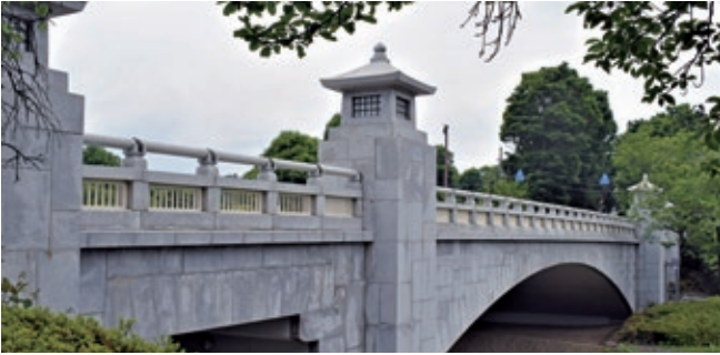
長命化工事が終了した南浅川橋
