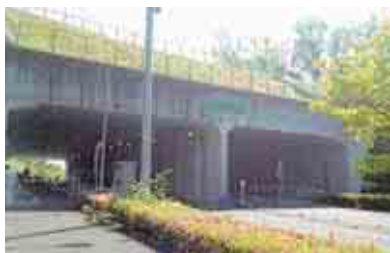
星谷坂トンネル現場
