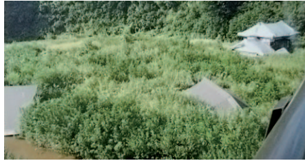
土砂で1,2階が埋まった家屋。3階だけが当時のまになっている
